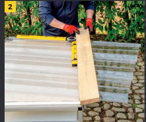
**3** Pour marquer les coupes en équerre, une fois la bonne mesure prise, une plaque intacte est superposée pour tracer la ligne de coupe, afin de suivre avec précision tous les reliefs.
