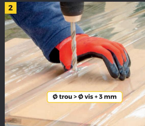
$\text{Ø trou} > \text{Ø vis} + 3 \text{ mm}$
