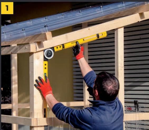
**1** Pour s'adapter à la pente du toit, des coupes inclinées doivent être effectuées ; détecter l'inclinaison précise à l'aide de la fausse équerre et la reporter sur la plaque, pour la marquer correctement.
