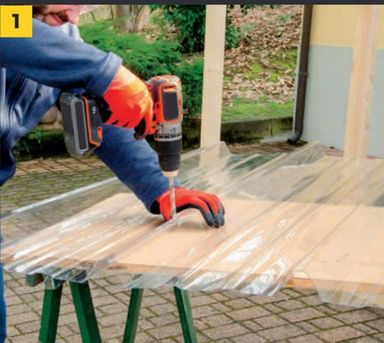
**1** Pour la première rangée de plaques, on peut percer avant même de les placer ; de cette façon, on procédera plus rapidement, mais il faut avoir soigneusement calculé la mesure du bord libre de la plaque au premier bandeau de fixation, au centre duquel les vis doivent être insérées.
