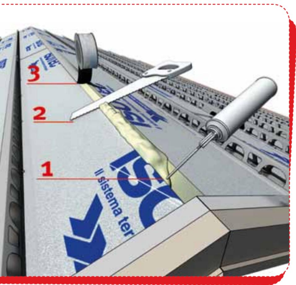
1. On procède à l'achèvement des autres pans, en arrivant jusqu'au faîtage, en scellant les derniers panneaux avec la mousse en polyuréthane (en faisant attention à remplir chaque cavité).
