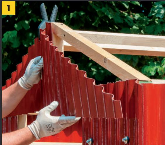
**1** Après avoir marqué les pièces spéciales pour recouvrir le tympan de l'abri, les découpes se font facilement, même si elles sont inclinées par rapport aux ondulations. Le conseil est de déplacer la meuleuse lentement, en suivant le marquage avec précision.
