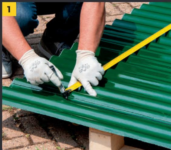
**1** Une fois la largeur totale du toit mesurée, calculer combien de plaques doivent être placées côte à côte pour le recouvrir. Le meilleur résultat esthétique est obtenu en amenant toutes les plaques à la même largeur, donc indiquer sur chacune la partie excédentaire à enlever.
